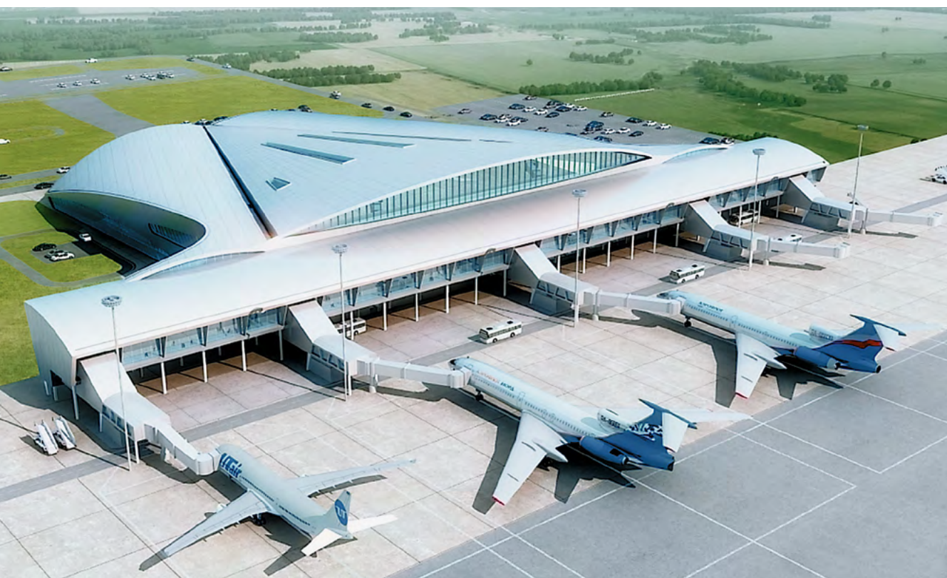
Крыша аэропорта «Курумоч» в Самаре покрыта мембраной с А-профилем, которая имитирует металлическую кровлю
