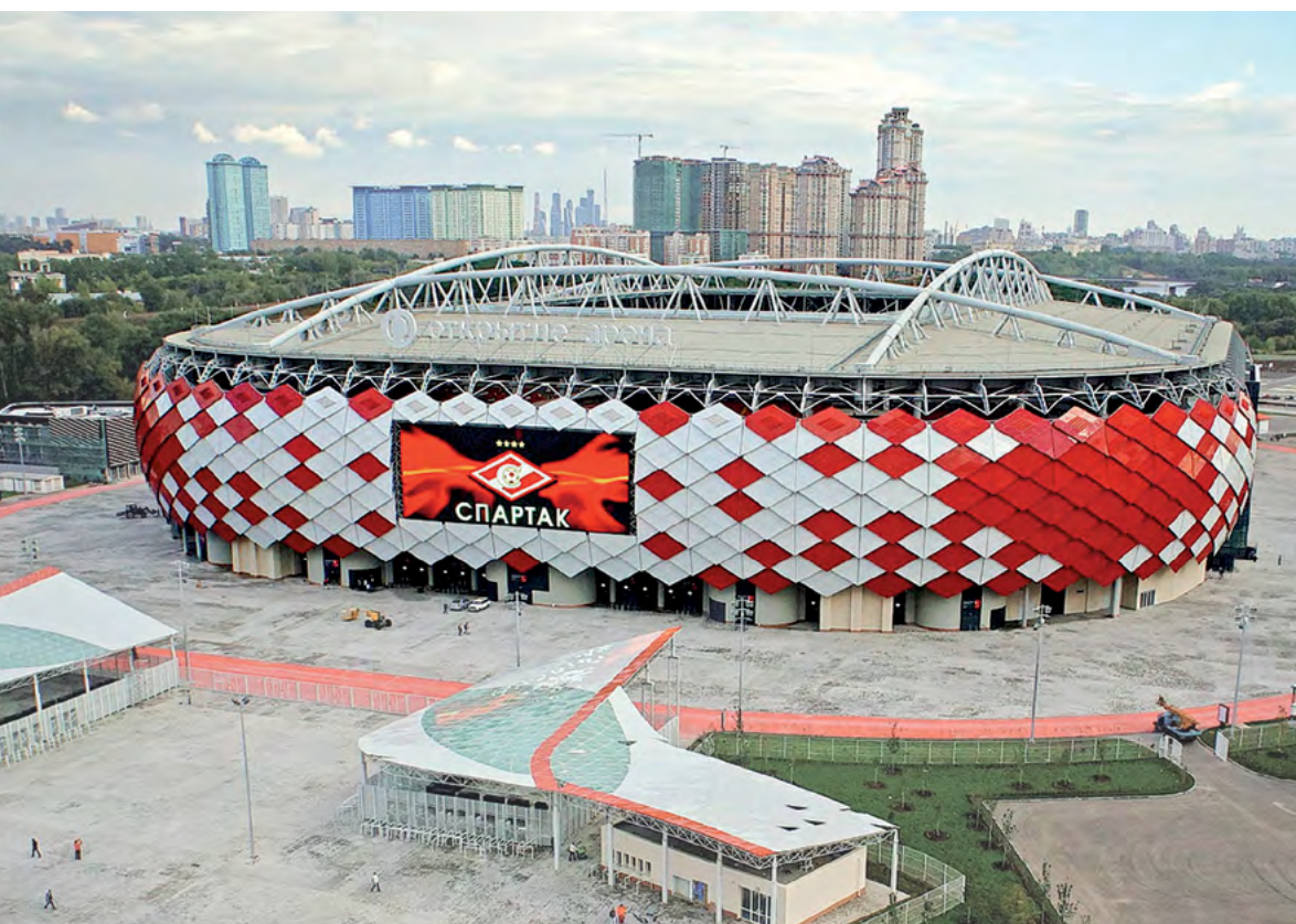
Для крыши стадиона «Открытие Арена» использована белая энергосберегающая мембрана
